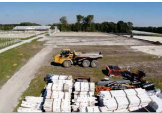
Die neuen Springplätze kurz vor der Fertigstellung.
